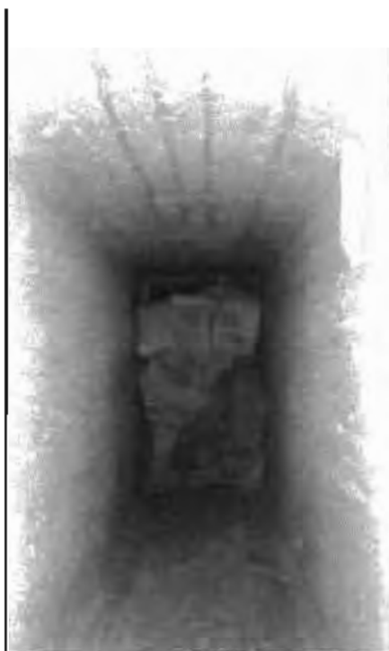
Фото 15, 16. Мусор в теле вытяжного канала в районе 24 этажа (4 подъезд, 3 строит., кв. №306).
