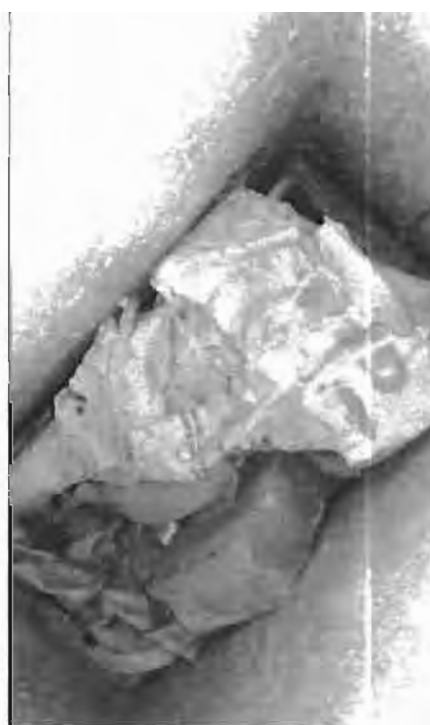
Фото 15, 16. Мусор в теле вытяжного канала в районе 24 этажа (4 подъезд, 3 строит., кв. №306).
