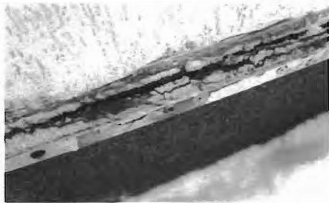
Фото 3, 4. Фрагмент примыкания гидроизоляционного ковра к стенке вентиляционной шахты в осях Жс-Кс/2с (по проекту шифр 07.001.74/14-04Б-АРЗ, 3 секция, лист 5). Разрушение герметика, образование ледяных и водяных линз под материалом гидроизоляции. Отслоение от стены материала гидроизоляции. Следы грязи и пыли на герметике и под прижимной металлической планкой. Трещины по поверхности герметика.
